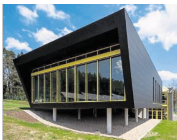
Bei der Erweiterung der Mittelspannungsnetzleitstelle in Neunburg vorm Wald dominiert eine klare Formensprache.
