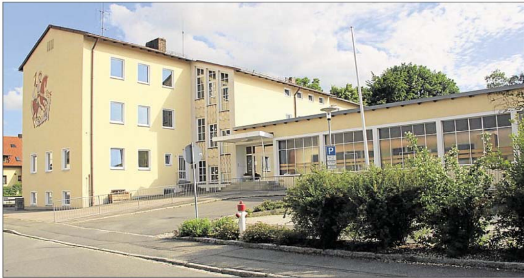
Erst nach der Sommerpause wird im Stadtrat die nächste Entscheidung auf dem Weg zur Einhäusigkeit der Grundschule fallen. Unter anderem sind noch genauere Untersuchungen der bisherigen beiden Standorte (hier das Schulgebäude in der Ledererstraße) nötig. Bild: Mardanow
