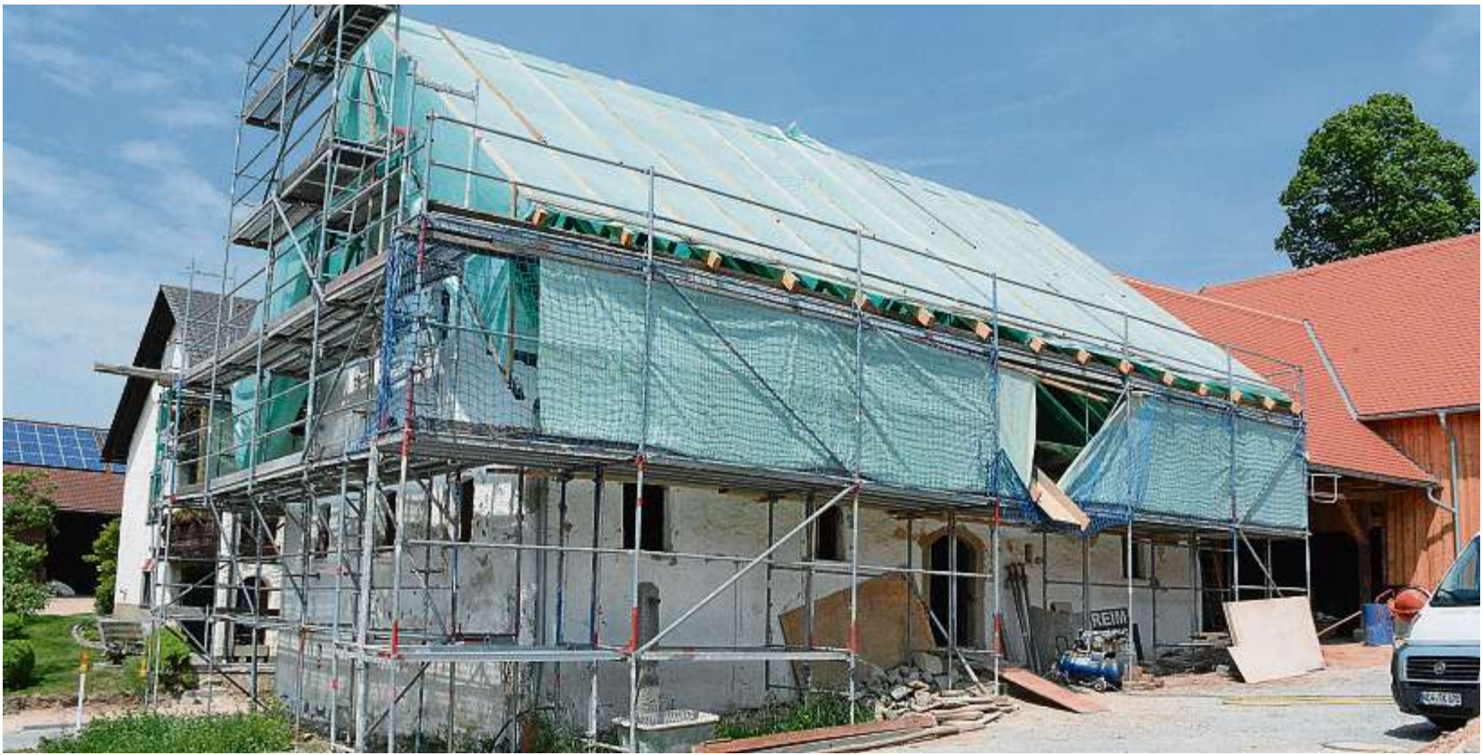
Im Dorfgemeinschaftshaus in Mitterauerbach sind die Sanierungsarbeiten in vollem Gange. Die blaue Folie ist nur ein Notdach.
