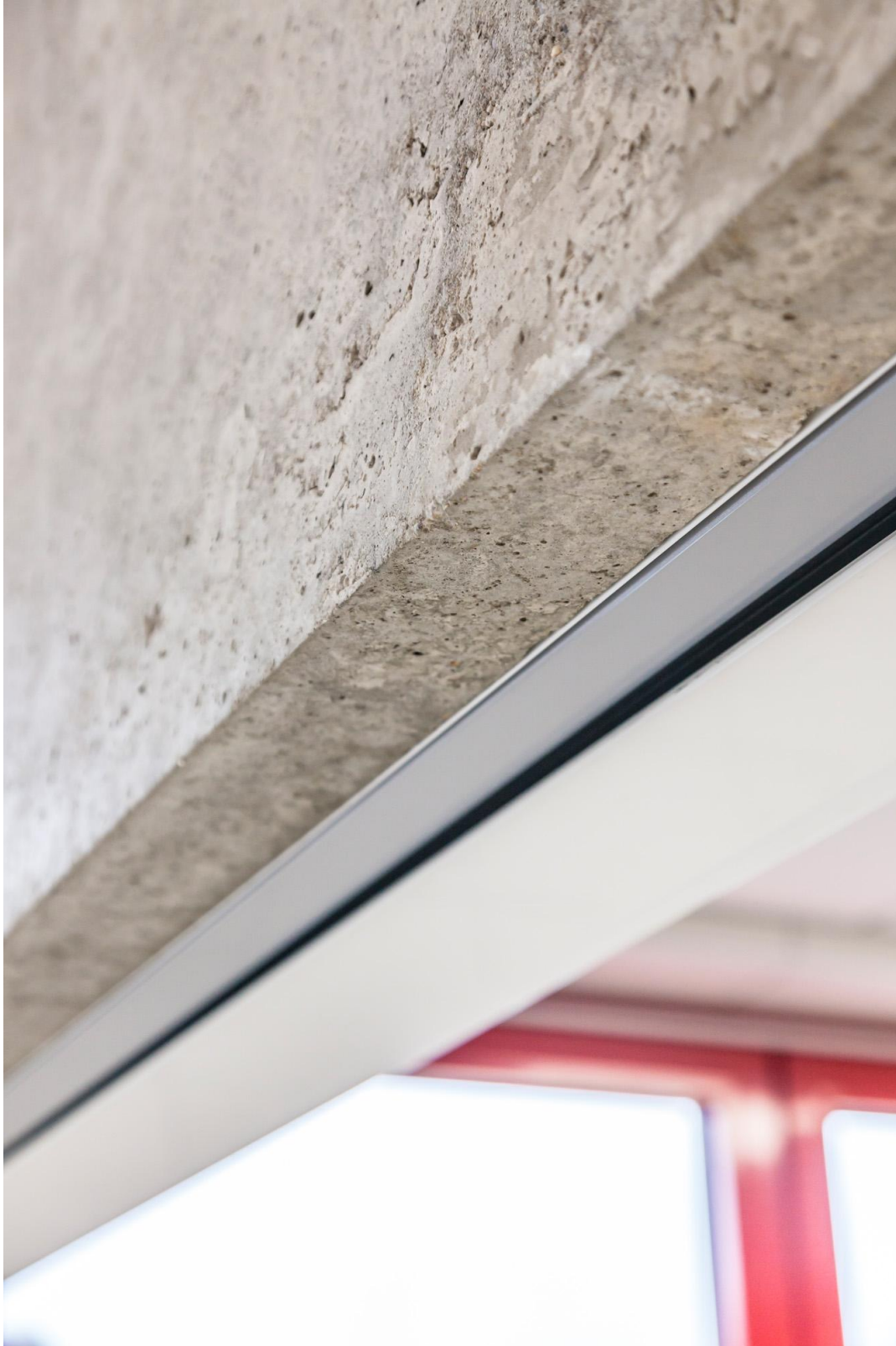
Abb. 5: Durch die perfekte Abstimmung von Schalung und Material und die sorgfältige Verarbeitung entstand eine nahezu organische Struktur der Oberfläche. (Foto: Architekturbüro Steidl)
