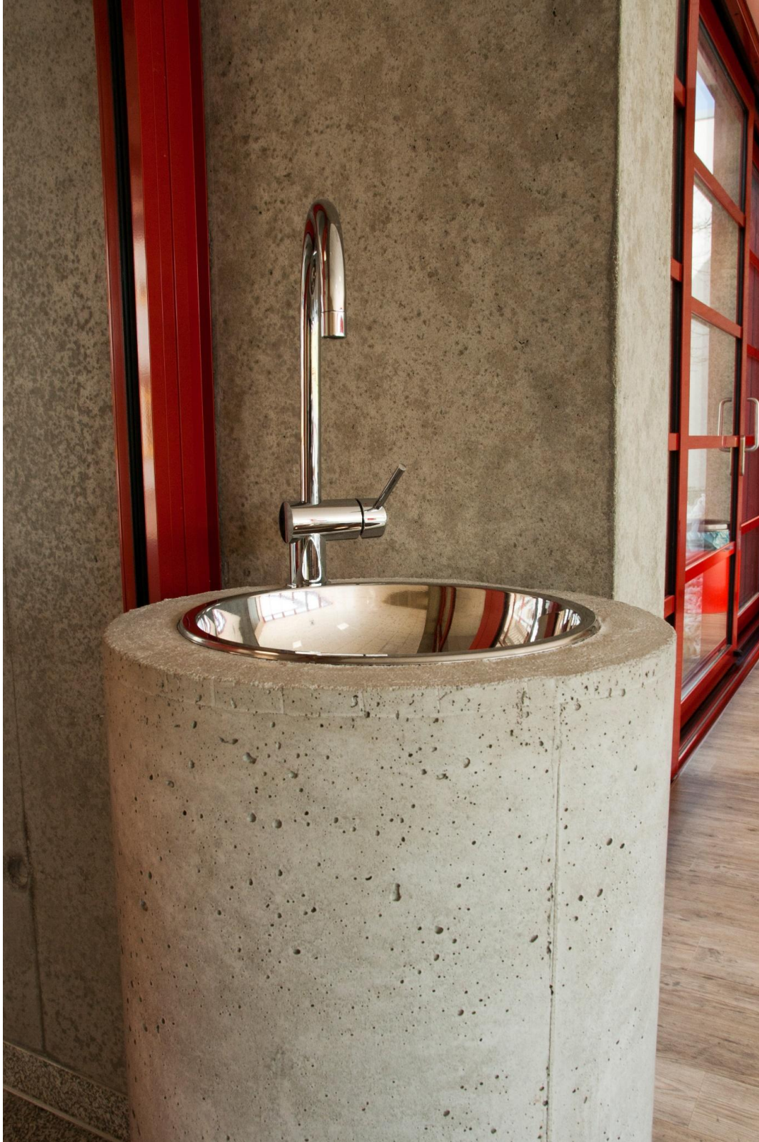
Abb. 9: Trinkbrunnen aus Beton. (Foto: Architekturbüro Steidl)
