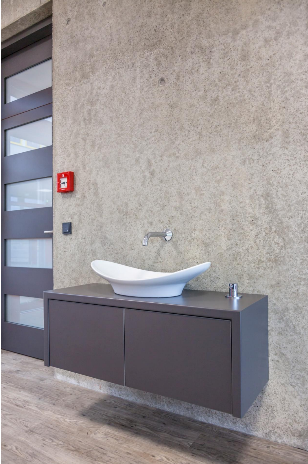
Abb. 8: Wert gelegt wurde auch auf puristische Details, wie diesem Wasserauslauf, der direkt aus der Betonwand ragt. (Foto: Architekturbüro Steidl)
